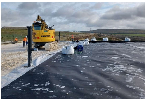
Mise en place de matériaux inertes sous et sur géosynthétiques (d'étanchéité et de drainage)
